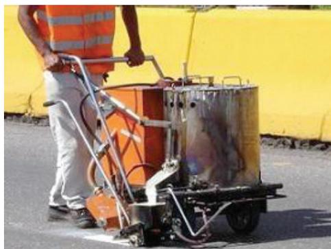
Fig.01: Equipo autopropulsado para la confección de demarcaciones termoplásticas en caliente.
